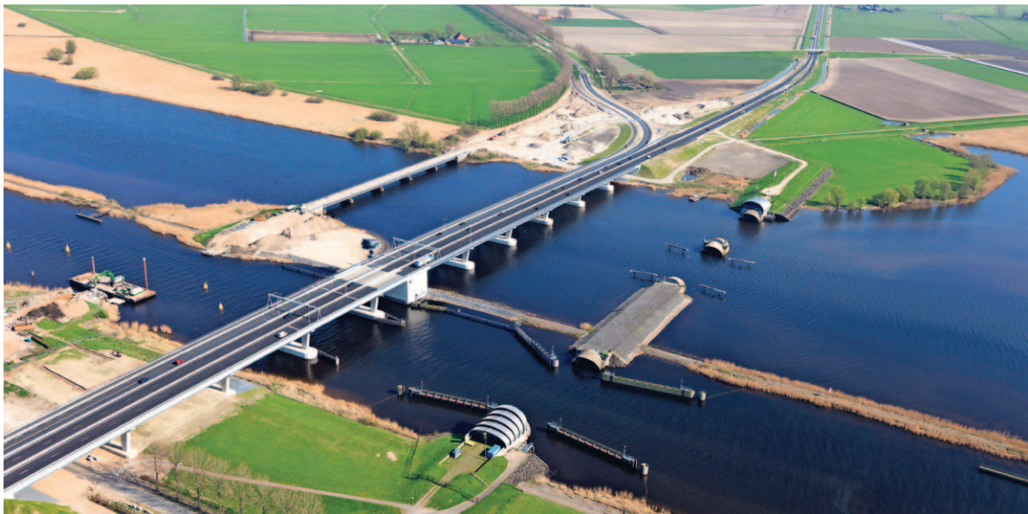
Ramspolbrug in de N50, de eerste energieneutrale beweegbare brug dankzij zonnepanelen. Foto: Hollandse Hoogte
